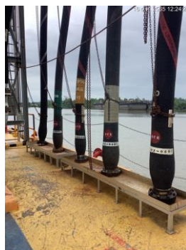
ภาพที่ 11 ถาดรองน้ำมันที่อาจรั่วหกและวาล์วที่ปิดกั้นน้ำมันปิดตลอดเวลาการขนถ่ายน้ำมันที่ทำ
